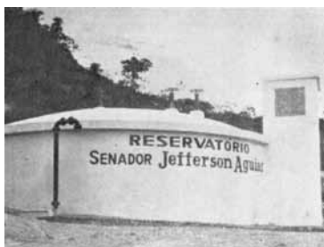
Reservatório, filtro e casa de tratamento do abastecimento d'água da cidade – 1963.
