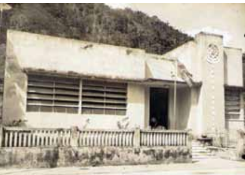
Antigo prédio do Grupo Escolar Teófilo Paulino – sem data.
