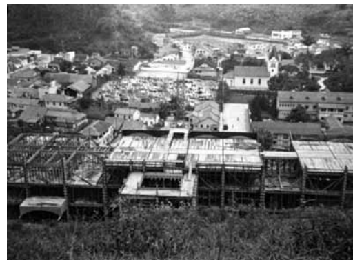
Outro estágio da construção do hospital - 1970.
