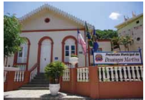
Atual Prédio da Prefeitura Municipal – Recuperado – 2011.
