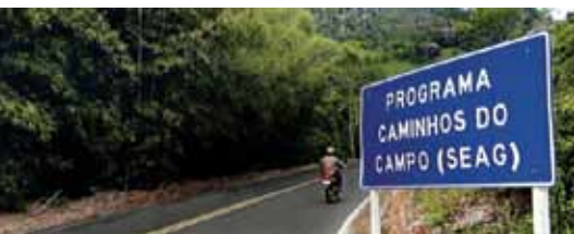
Rodovia que liga a Sede de Domingos Martins às comunidades de São Miguel e Melgaço – 2012.
