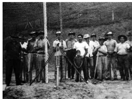
Operários encarregados da construção do Hospital – 1970.
