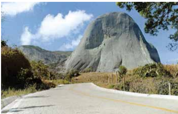
Pavimentação da rodovia Mário Módolo – ligação da BR-101 ligando a Vila Pedra Azul a rodovia Geraldo Sartório – 2012.
