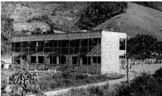
Uma das etapas da construção do ginásio ainda sem o reboco – 1966.
