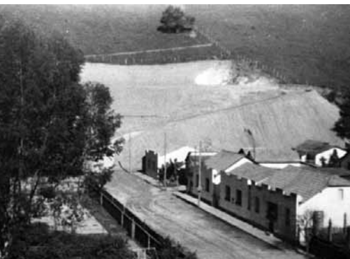
Uma das fases da terraplanagem da área do futuro hospital – 1970.
