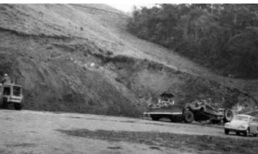
Outra fase da terraplanagem – 1970.
