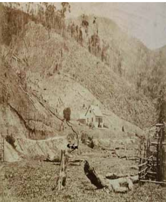
Primeira casa construída na colônia Santa Isabel – Residência do diretor da Colônia – 1858/1860.
