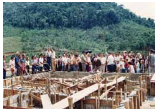
Início da construção do prédio escolar – 1995.
