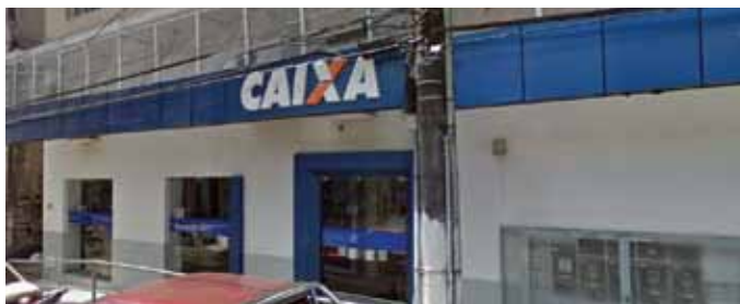
Agência da Caixa Econômica – 2012
